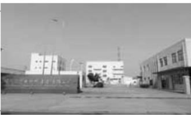
厳格な検閲規制に対応するための投資も継続(南通市の工場)
